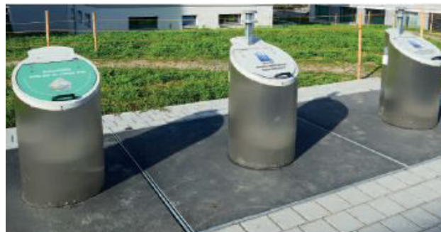
Unterfluranlage mit zwei UFC für Kehricht und einem Liftomaten für Grüngut.
