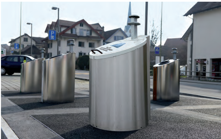
Die UFC-Anlage in Mettmenstetten
